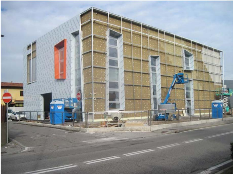
Realizzazione dei nuovi edifici adottando tecniche costruttive ed impianti che garantiscono un'alta prestazione energetica: prefabbricati con isolamento termico, cappotto esterno e impianti di condizionamento a pompa di calore.
