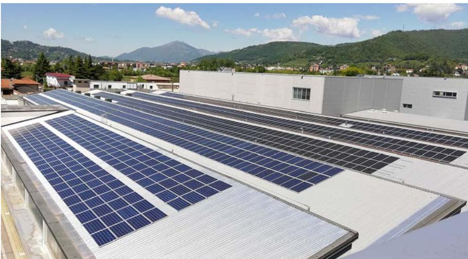
*Impianto fotovoltaico in grado di produrre 450.000 kWh annui pari al 15% dell'attuale consumo aziendale di energia elettrica, raggiungendo un incremento dell'auto-produzione di energia elettrica da fonte rinnovabile di circa il 150 % (+ 270.000 kWh/anno).*
